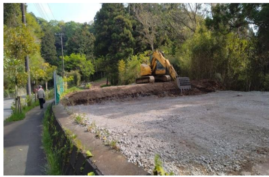
北口外の不法投棄物の穿り回収跡・先週整地後
