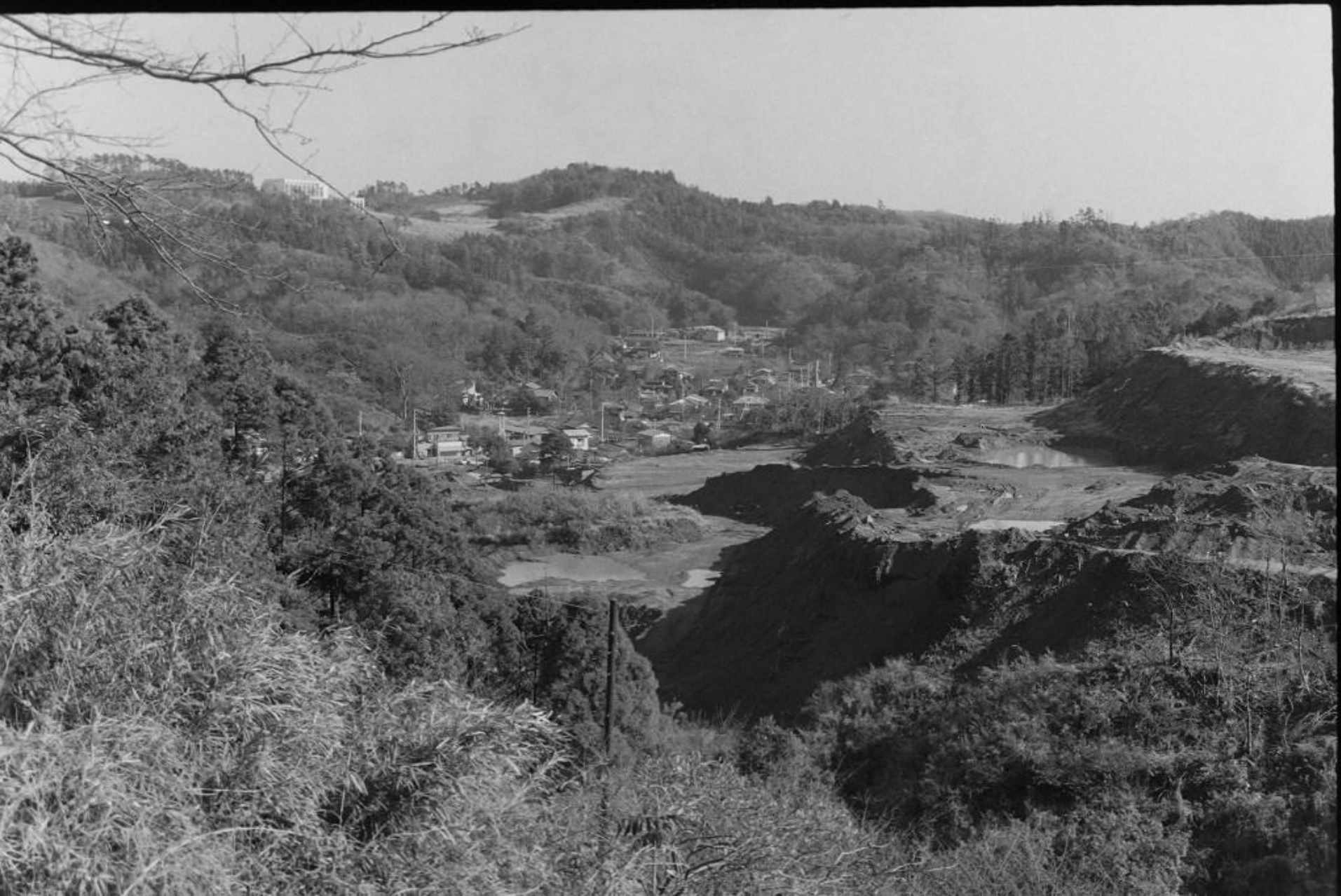
宅造中の仲ノ坂住宅地(昭和43年)
