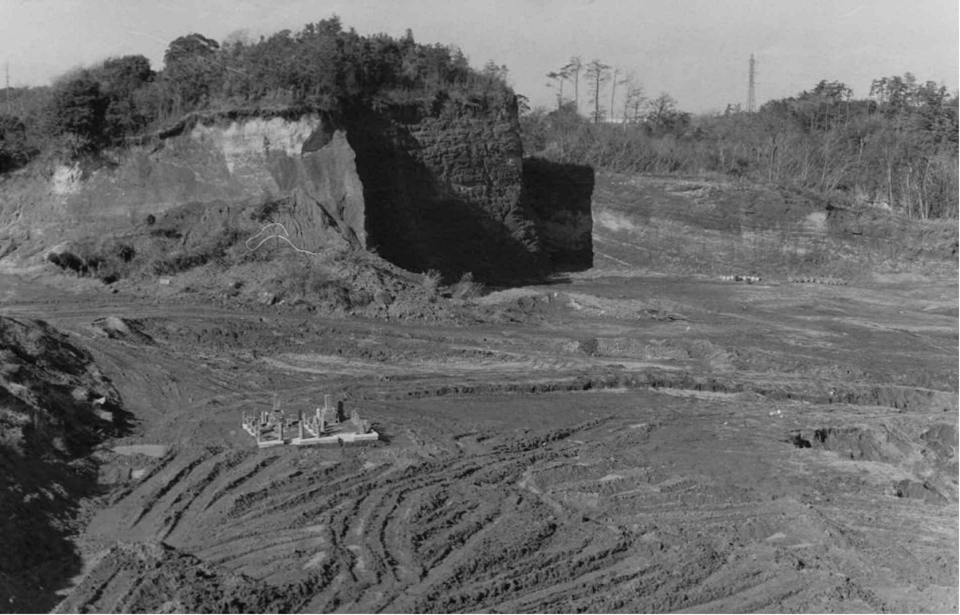
宅造中の縦堀(現笛田4丁目)
