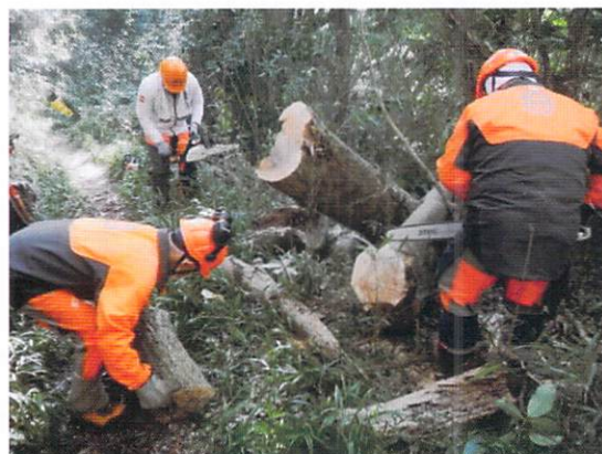
六国見山の倒木撤去作業の様子
