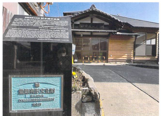
新たに設置された登録有形文化財のプレート
